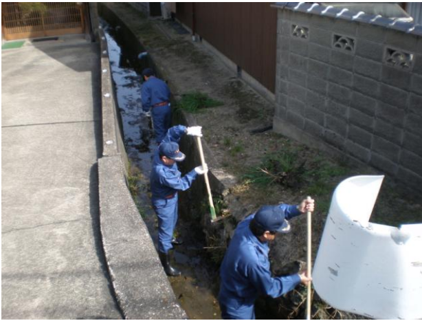
(地域の水利確保の為、用水路の清掃作業)
