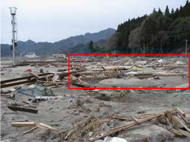
（ 1 ）津波により流出した消防屯所（赤線囲み内）
