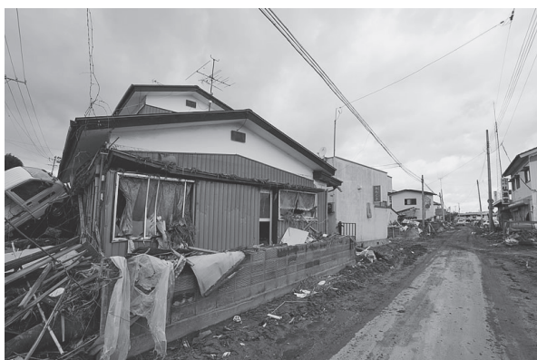
常磐線山下駅周辺
