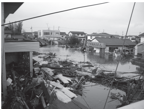
浸水被害の状況
