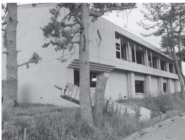
建物2階部分の窓ガラスが壊れている
