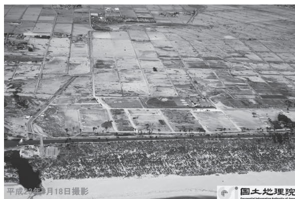
被災した荒浜航空分署付近（国土地理院）
