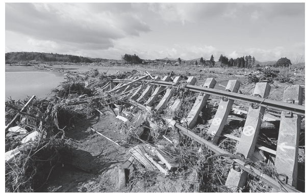
中浜地区の常磐線線路
