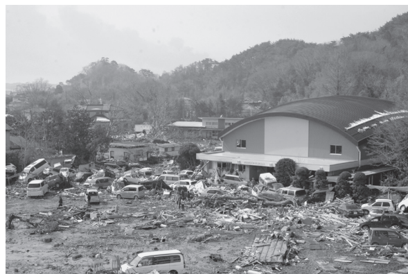
避難した約350人のうち高齢者ら約40人が犠牲になった野蒜小学校体育館
