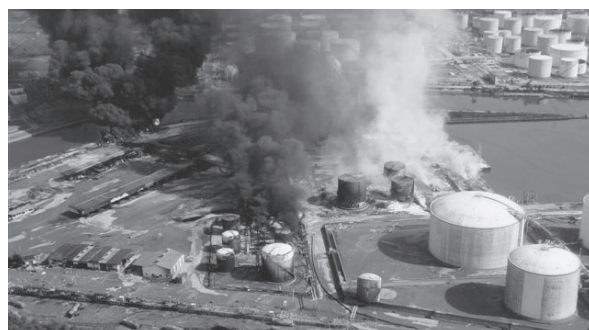
J X日鉱日石エネルギー(株)仙台製油所火災
