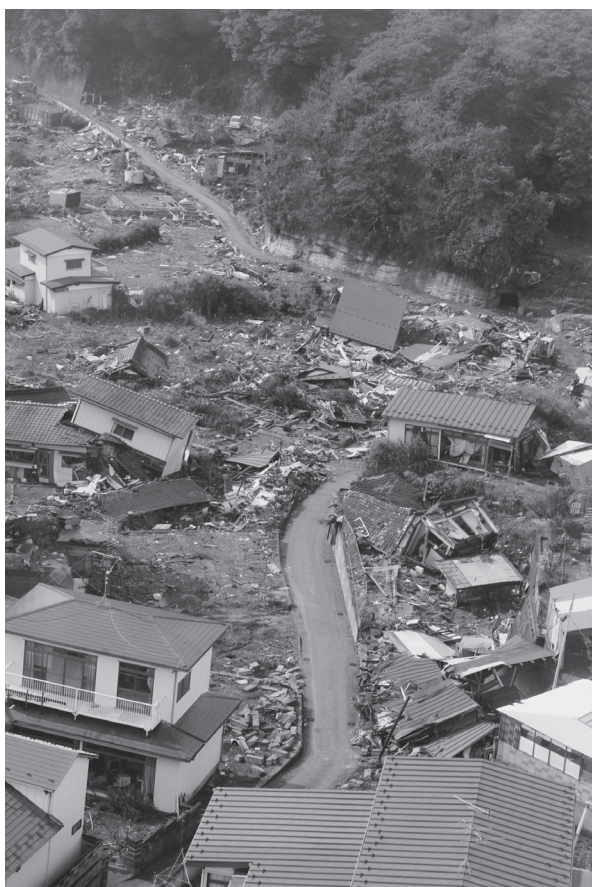
津波が運んだ瓦礫で家屋にも被害が発生（桂浜地区）
