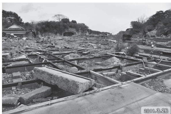
土台を残して全て流出した（3月26日撮影）
