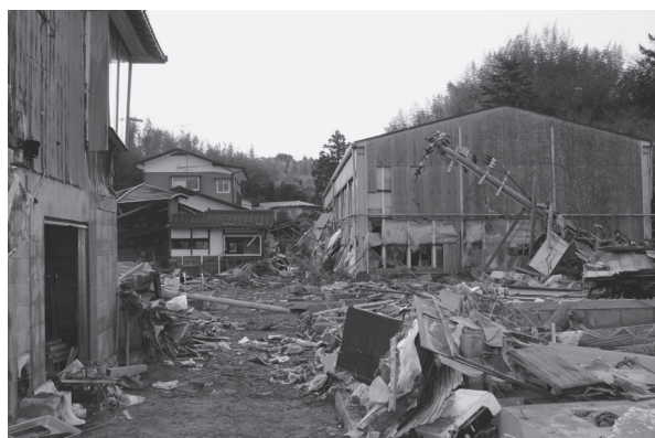
家屋も壊滅状態
