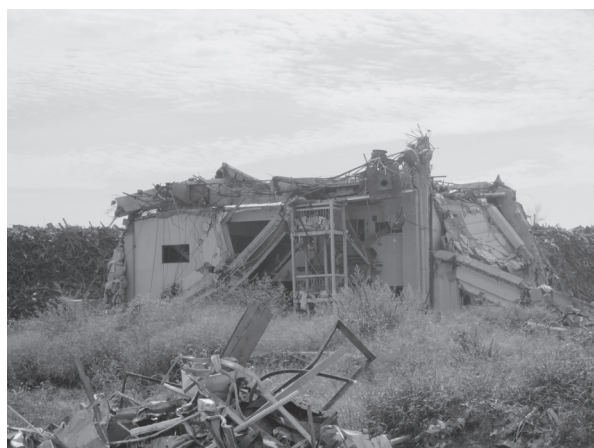
崩壊したコンクリート製の建物
