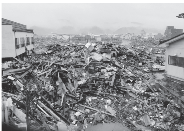
鹿折地区の被災状況
