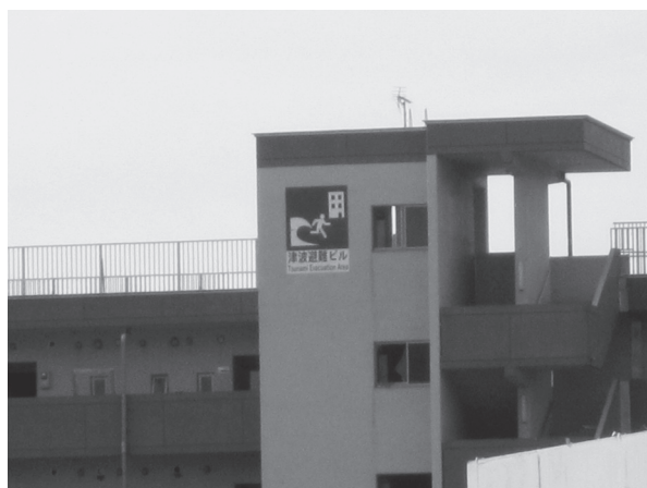
津波避難ビルに指定されていた建物
