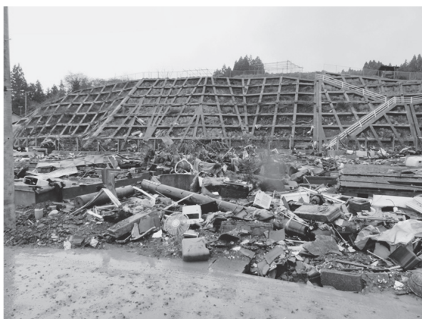
本吉町大沢漁港の被害状況
