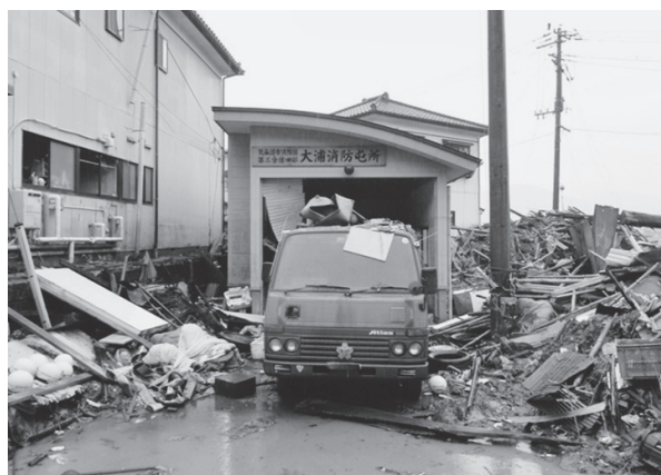
被災した大浦消防屯所
