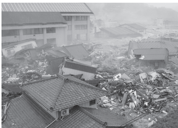
悪夢を見ているような光景だった（女川町提供）
