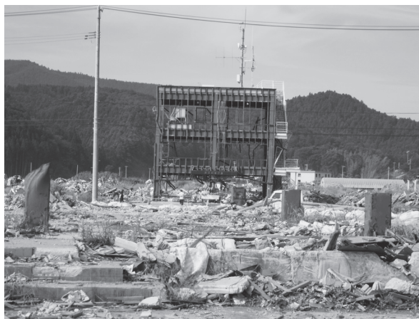
津波に津波に襲われ鉄筋の骨組みだけが残った防災対策庁舎
