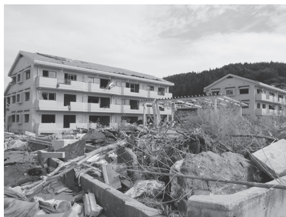
津波により破壊され荒廃してしまった建物
