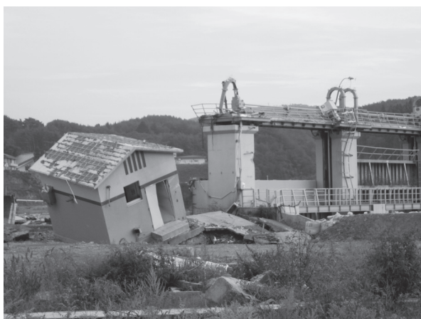
津波被害を受けた水門
