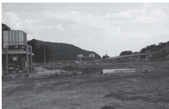
被災状況（大船渡市内）
