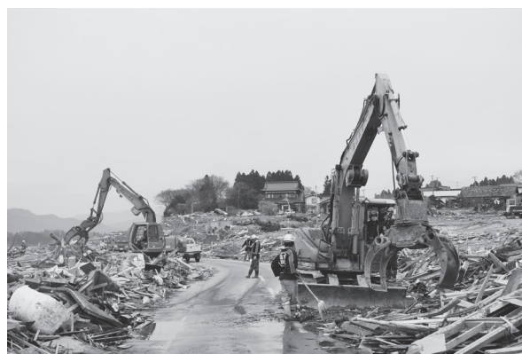
重機による道路の瓦礫撤去（自衛隊提供）
