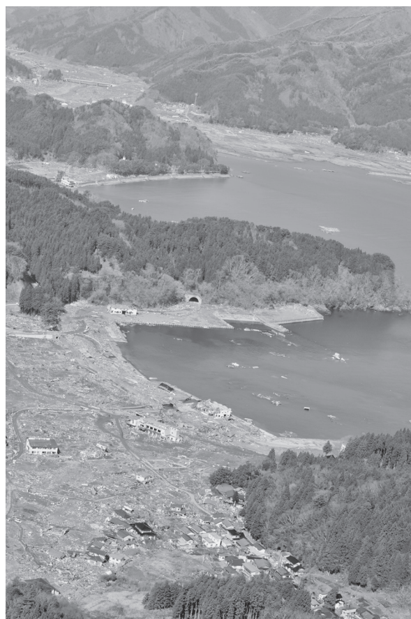
箱崎地区の被災状況（岩手県消防協会提供）
