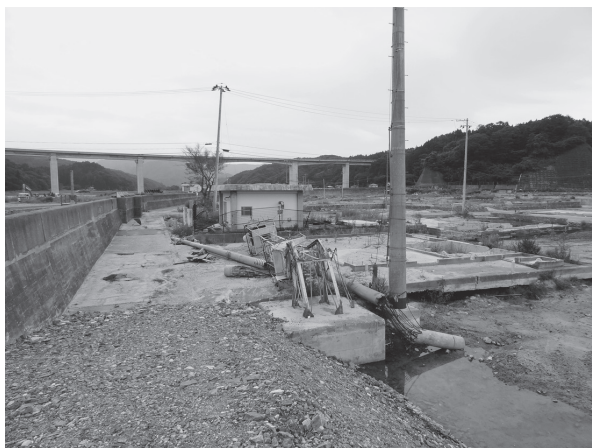
流出した屯所跡
