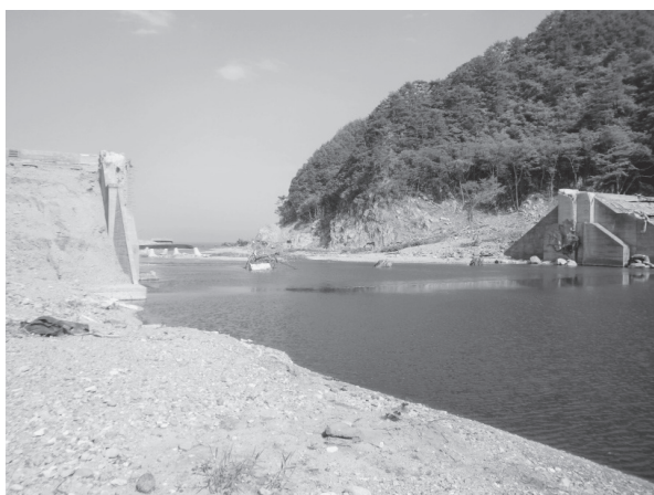
被災後の下摂待水門
