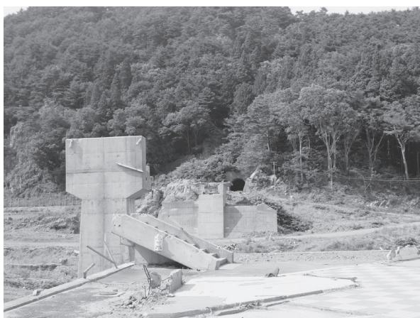
三陸鉄道のトンネルと残された高架
