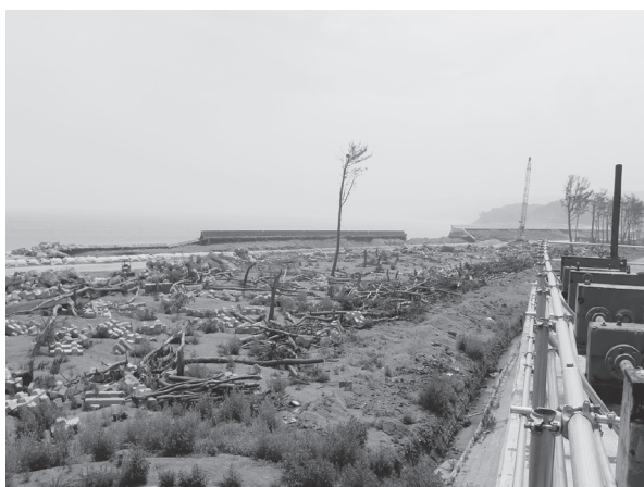
水門の上から海岸を望む。防潮林がなぎ倒されている。
