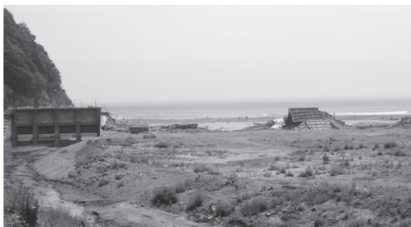
破損した防潮堤
