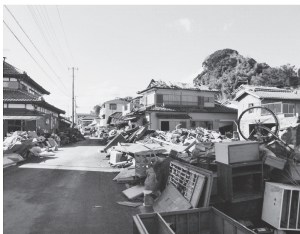
損壊した家屋や瓦礫が点在（大津地区）
