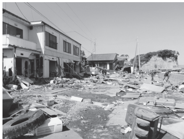
津波が押し寄せ瓦礫が散乱（平潟地区）
