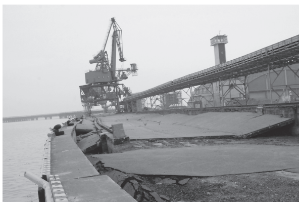
港湾部の被害状況
