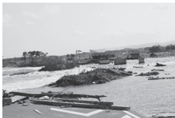
津波により見る影もない新地町大浜地区
