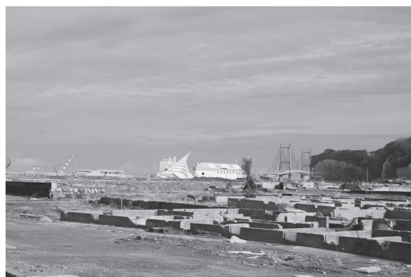
相馬市原釜尾浜海水浴場付近の被災状況
