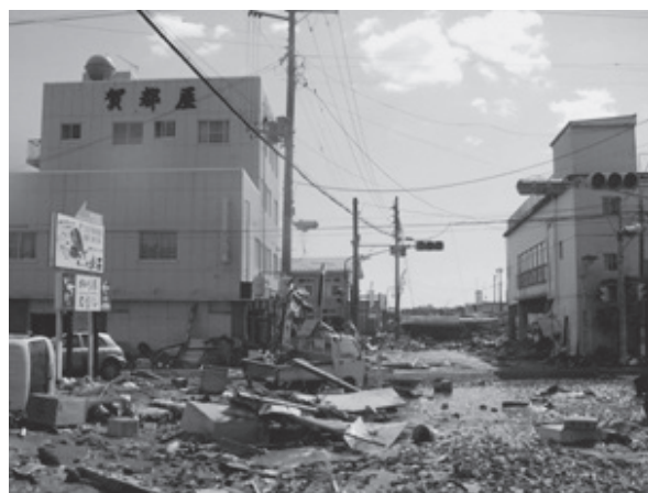
相馬市尾浜の被災状況
