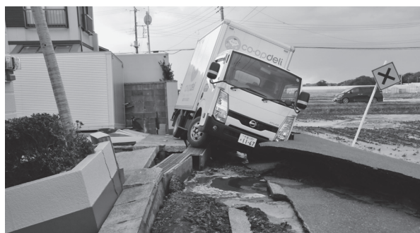
液状化による道路崩壊
