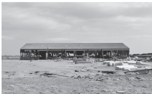
市川船だまりの漁港倉庫
