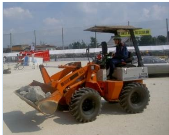
ホイールローダーによる瓦礫除去
