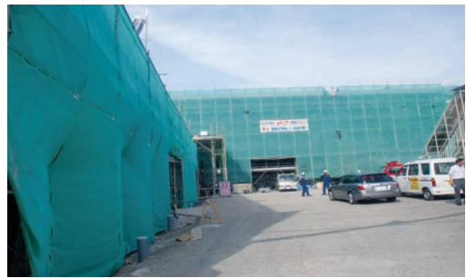
新庁舎建築現場の様子
