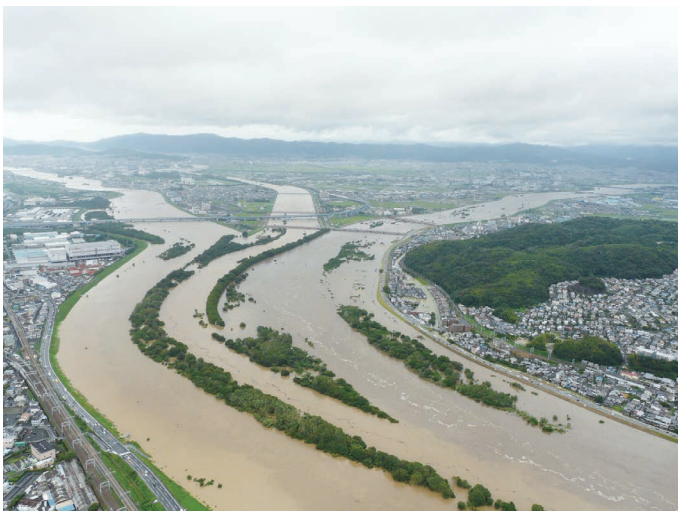
台風18号による三川合流点付近の状況、写真国土交通省提供
