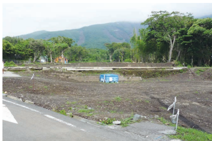
元町中心地を襲った土石流現場
