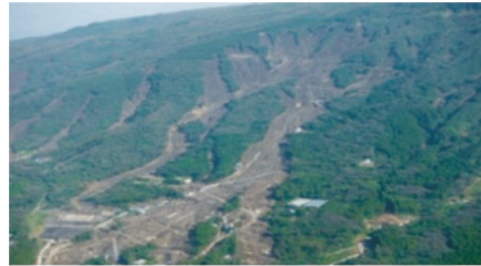
平成25年台風第26号の被災現場（東京都大島町） （さいたま市消防局提供）
