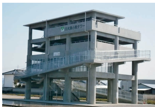
避難タワー（大湊小南タワー）
