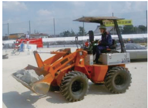
ホイールローダーによる瓦礫除去
