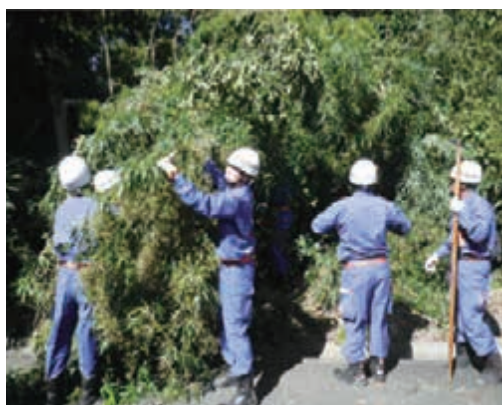
道路を封鎖した立木の撤去作業
