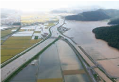
北川支流の野木川堤防が決壊（中央右）
