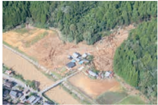
土砂崩れにより住宅など4棟が全壊（小浜市忠野）
