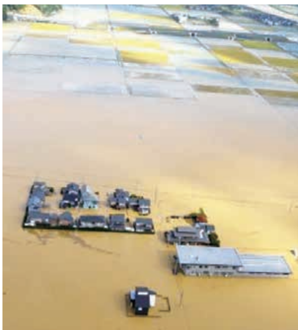
冠水した小浜市江古川区
