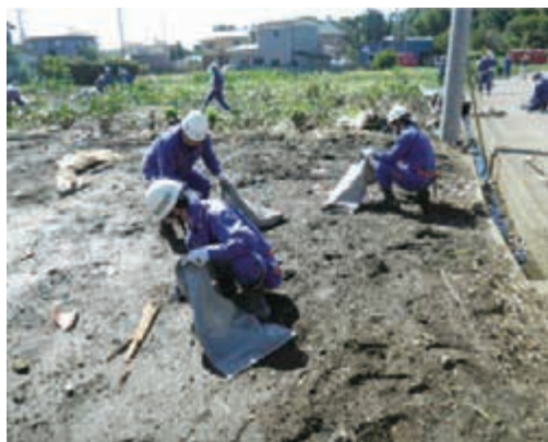
畑や空き地に飛散したがれきの撤去作業
