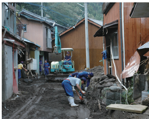
平成17年台風14号による水害後の災害復旧活動
