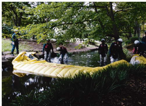
貯水シートの設置状況
