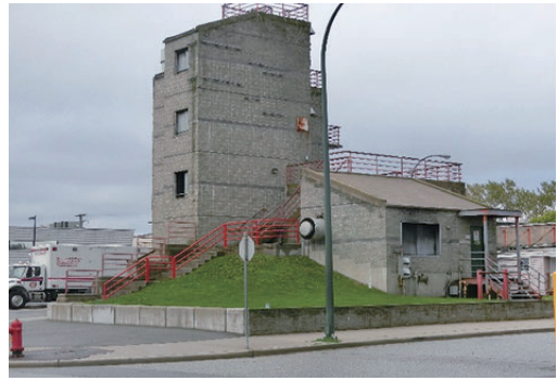
(消防訓練施設)
