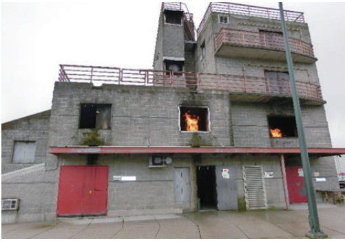
(消防訓練施設)
