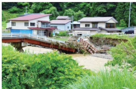
金山地区 白山在家橋崩落
