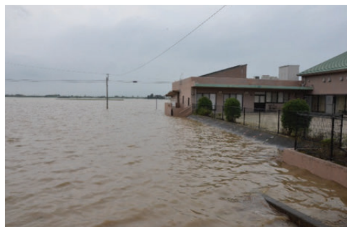
九州北部豪雨により冠水した地区
