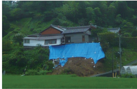
岩目地区 住宅下法面崩落
