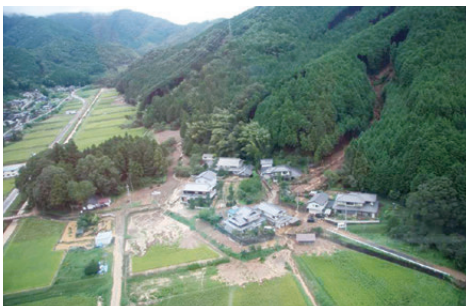
丹波市市島町徳尾地内（谷上）土砂災害の状況
