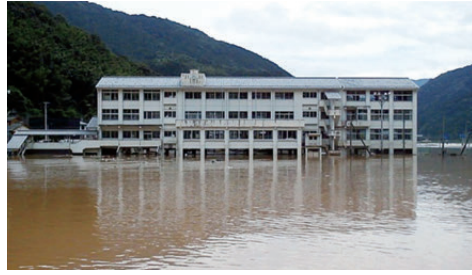
阿南市加茂町 加茂谷中学校 1階の浸水状況
