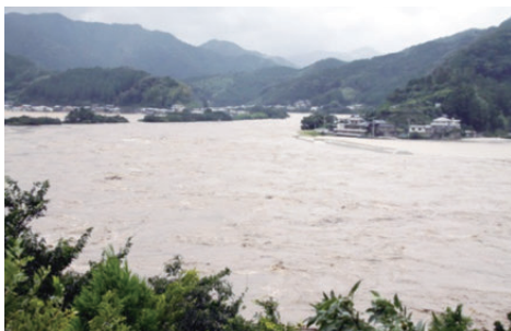
阿南市深瀬町 那賀川の氾濫状況
