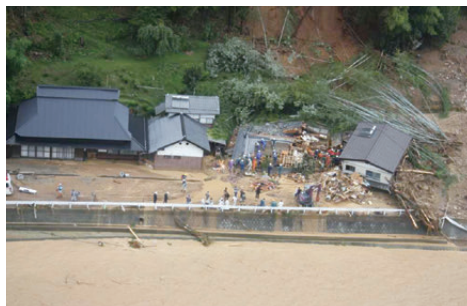
丹波市市島町徳尾地内（下鴨阪）土砂災害の状況
