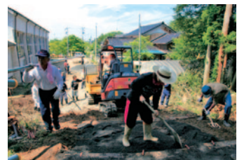
避難路整備の様子 (出典：第17回防災まちづくり大賞)
