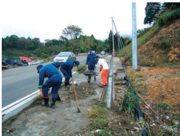
土砂撤去作業
