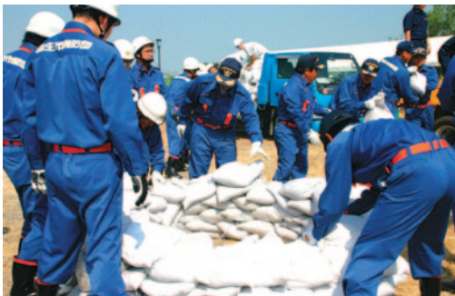
水防工法訓練
