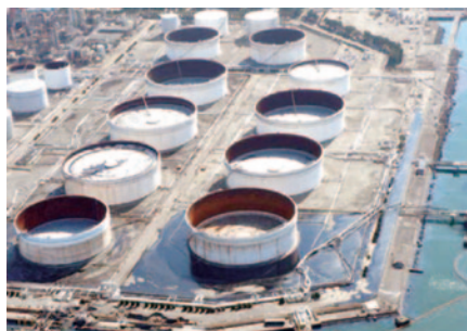
津波により屋外タンク貯蔵所の配管が破壊しタンク内の危険物が流出した状況（仙台市消防局提供）
