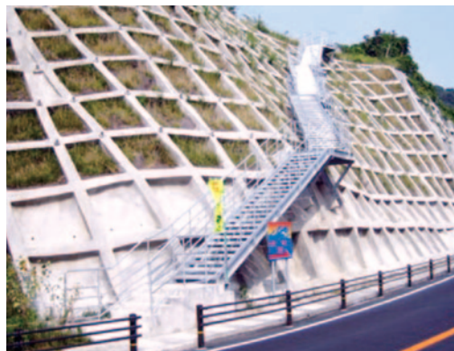
避難階段(静岡県沼津市提供)
