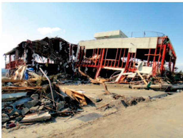
3.11東日本大震災被災状況
