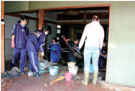
平成24年10月21日 南三陸町波伝谷地区でのがれき撤去活動 (写真提供：宮城県南三陸町ボランティアセンター)
