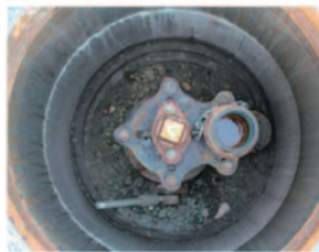
地下に埋設された消火栓の内部
