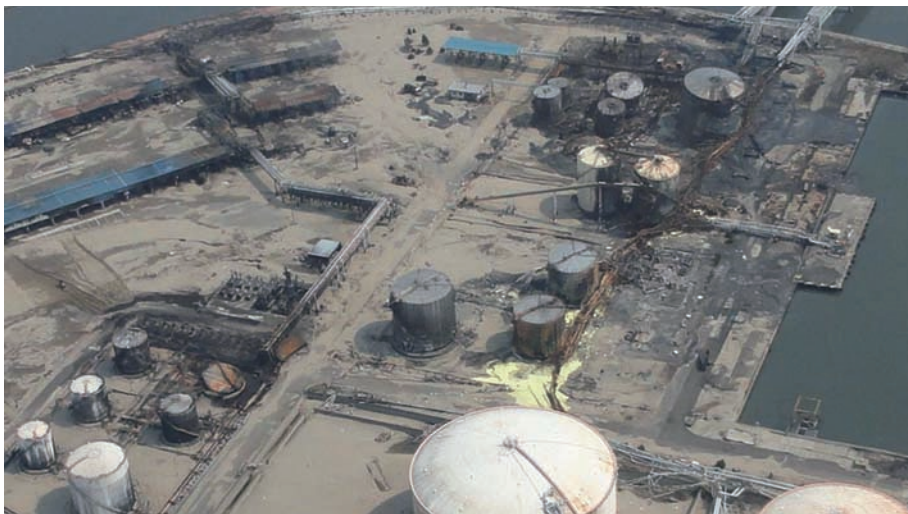
製油所の被災状況の写真
