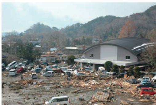
野蒜小学校体育館
