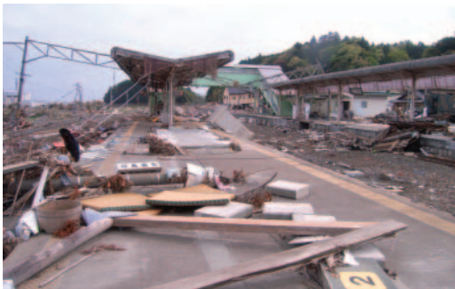
津波に飲まれた富岡駅（写真左側より津波襲来）
