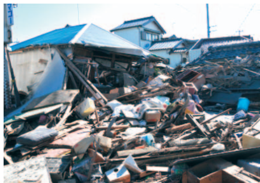
旭市市内の地震被害
