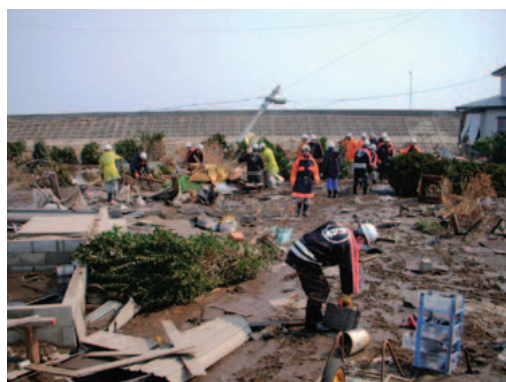
津波後の道路啓開作業
