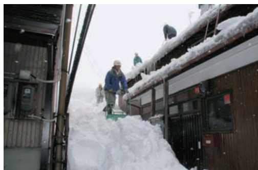
地域の協力による除雪作業 (写真提供:新潟県南魚沼市)
