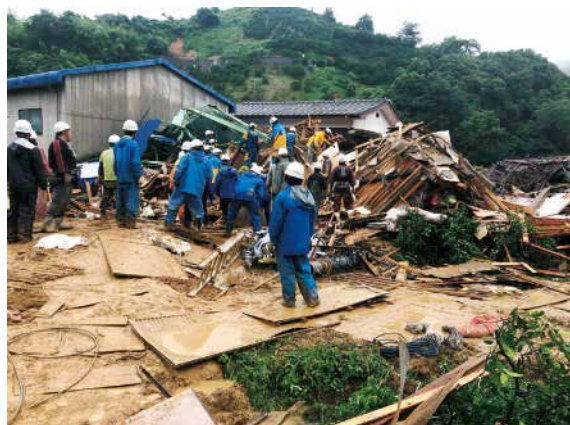
大雨による土砂崩れ現場での活動
