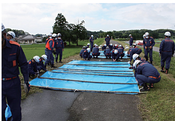
③シート張り工法【堤防の洗掘防止】
