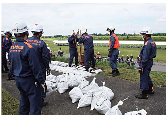
①積み土のう工法【河川の越水防止】
