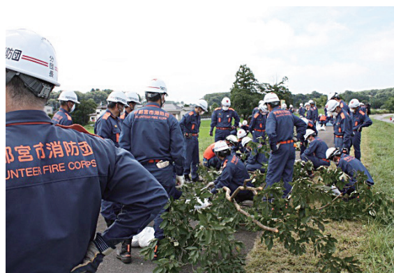
②木流し工法【堤防の洗掘防止】
