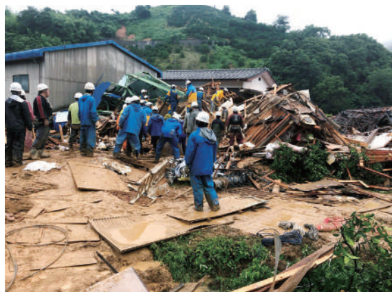
大雨による土砂崩れ現場での活動
