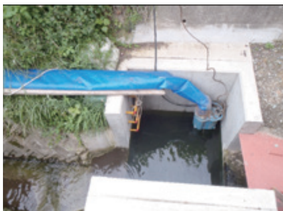
樋管ピット状況（川端地区）
