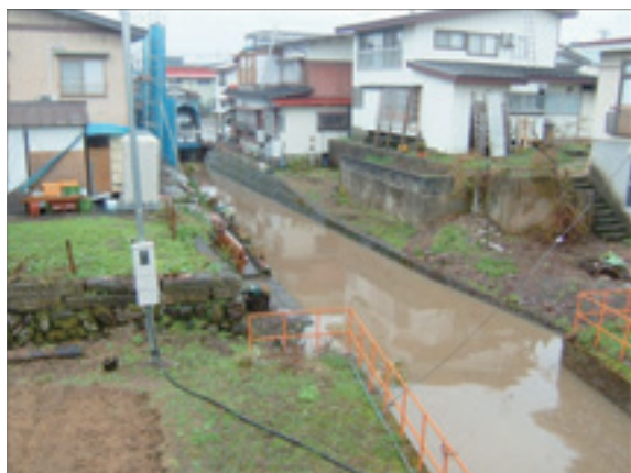
樋管ピット状況（下宿地区）
