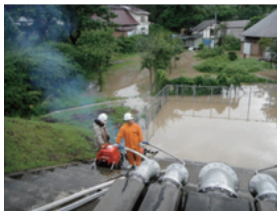
団小型ポンプでの揚水
