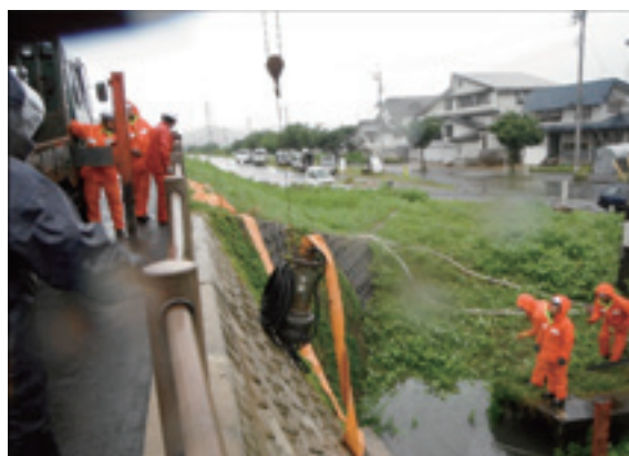
ユニック車でのポンプ投入
