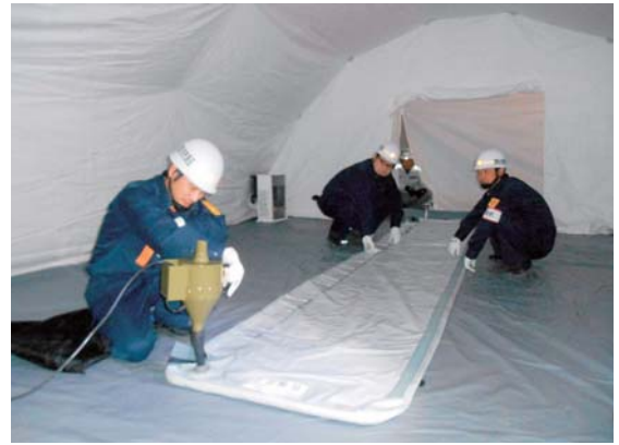
エアータントの設営
