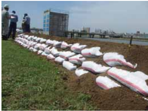
3段積土のう工法完成
