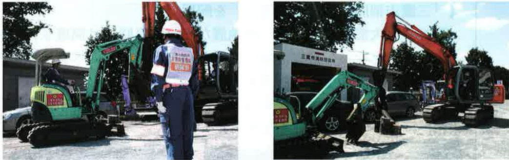
総合防災訓練における重機隊の活動
