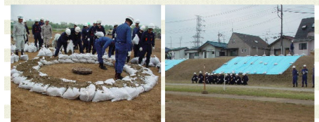
マンホール噴出防止工法作成中 シート張り防止工法待機中
