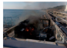
東京電力(株)福島第一原子力発電所 4号機の火災(東京電力HP(4月12日撮影)より)
