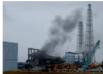
東京電力(株)福島第一原子力発電所3号機 (東京電力HP(3月21日撮影)より)
